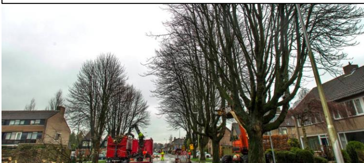
Herstel en onderhoud karakteristieke laanstructuur
